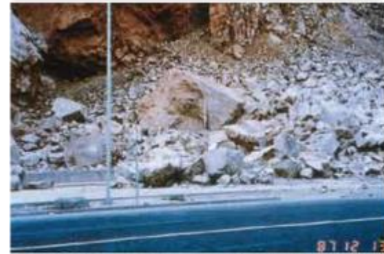
Desprendimiento rocoso inducido por el sismo del 8 de Agosto de 1987, en el flanco norte del Morro de Árica, Región I. Un operador porta una mira de 4 mts de alto, para destacar un bloque de 280 toneladas (Foto de Ingeniería y Geotécnica Ltda)
