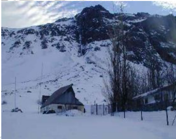
Baños Morales - Refugio dañado por avalancha.
