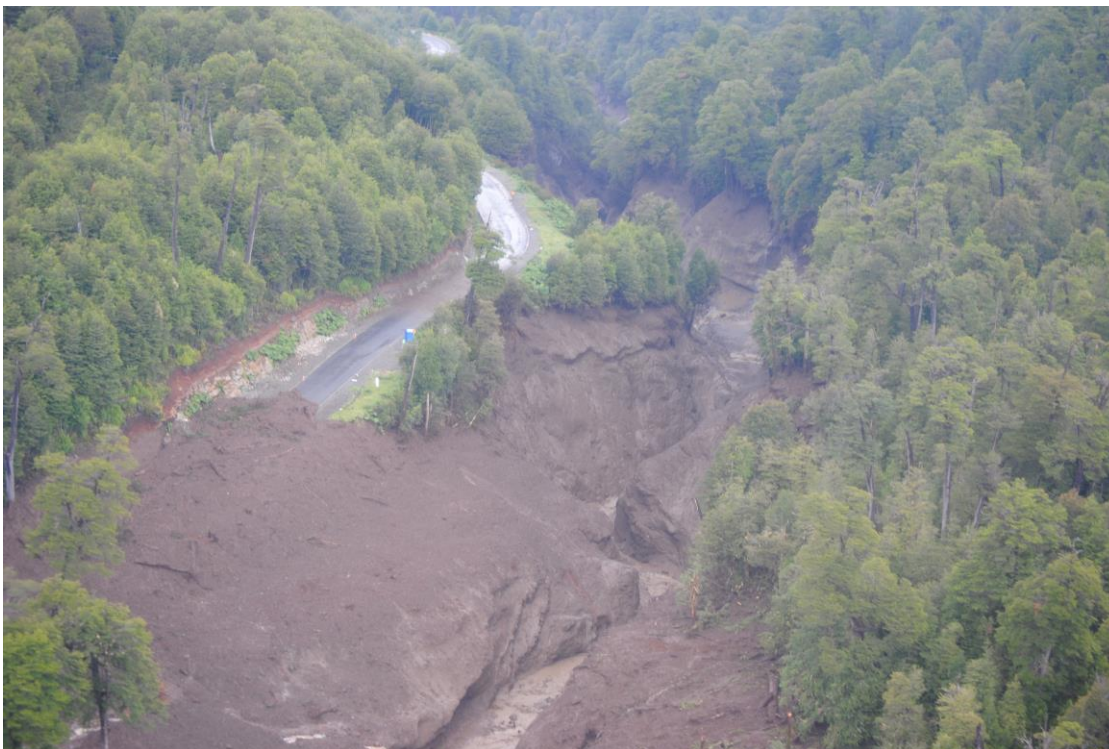
Foto 3. Afectación de Ruta-7.
