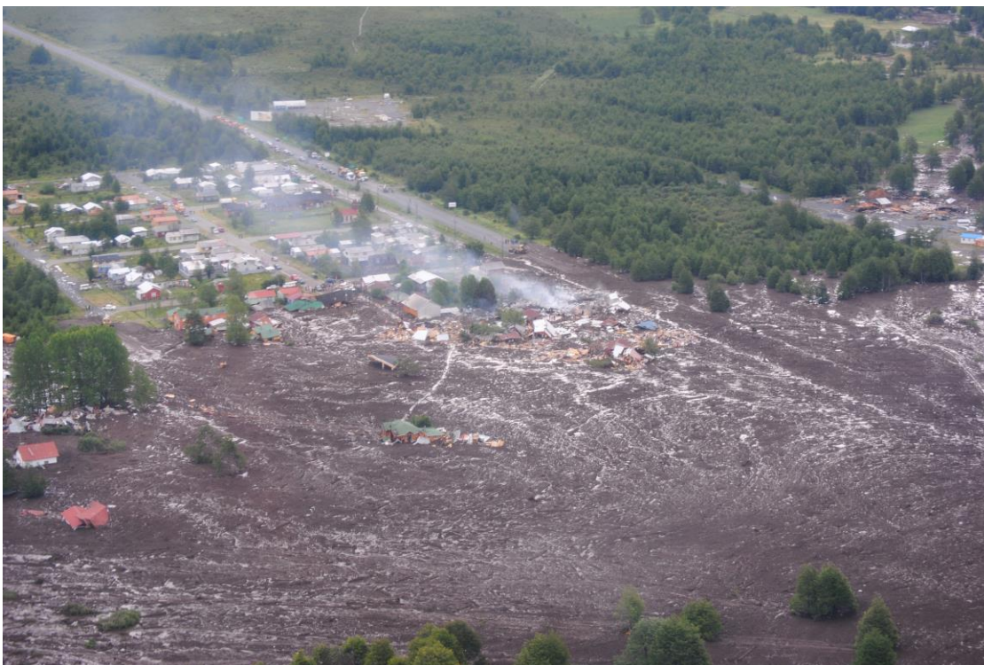
Foto 2. Afectación en Villa Santa Lucía.
