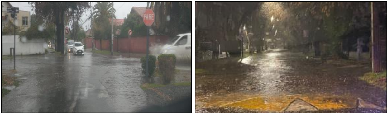
Figura n°12: Fotografía sector inundable de punto crítico. Fuente: M. La Reina – UGRD.
