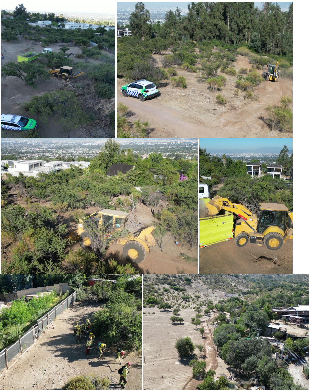
Figura n°18: Collage trabajos de cortafuegos en zona de interfaz. Fuente: M. La Reina – UGRD.
