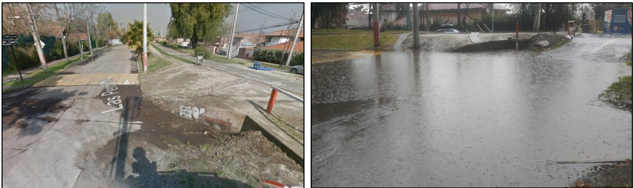
Figura n°24: Fotografía sector inundable de punto crítico. Fuente: M. La Reina – UGRD.
