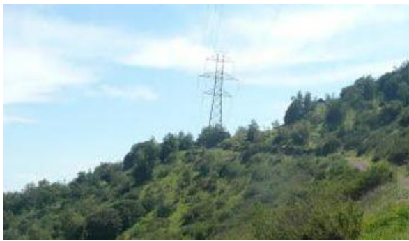
Figura n°13: Línea de alta tensión. Fuente: M. La Reina – UGRD.
