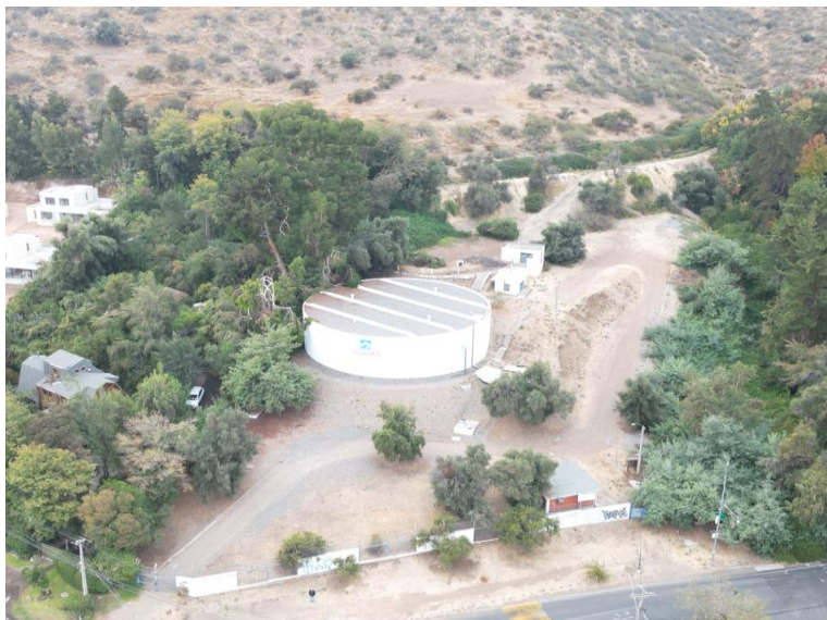
Figura n°14: Estanque Agua Potable, Aguas Andinas S.A. Fuente: M. La Reina – UGRD.
