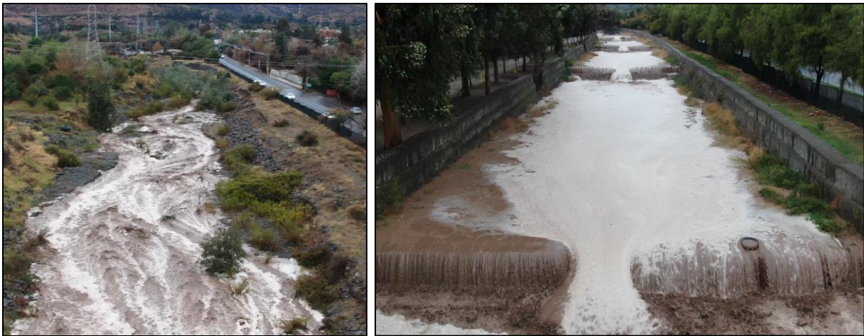
Figura n°33: Fotografía activación de quebrada punto crítico. Fuente: M. La Reina – UGRD.
