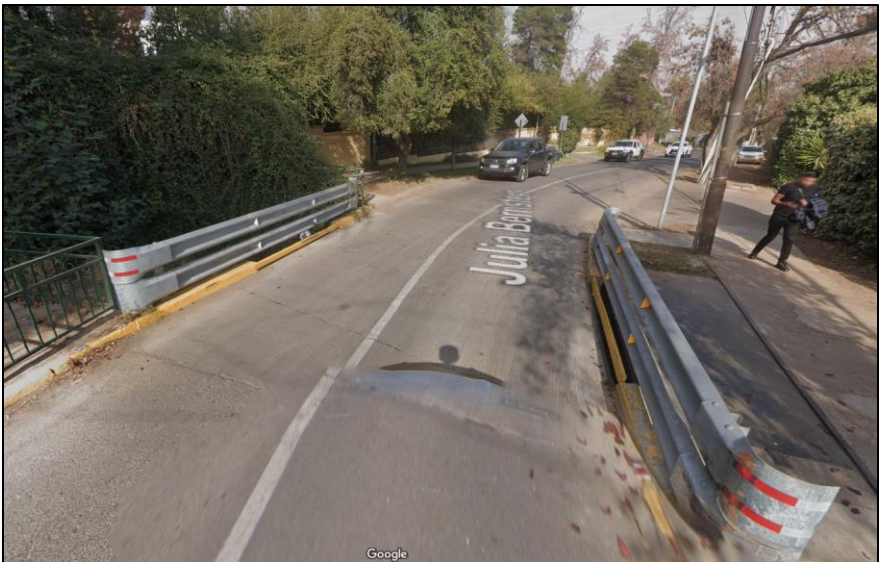
Figura n°28: Fotografía sector inundable de punto crítico. Fuente: M. La Reina – UGRD.
