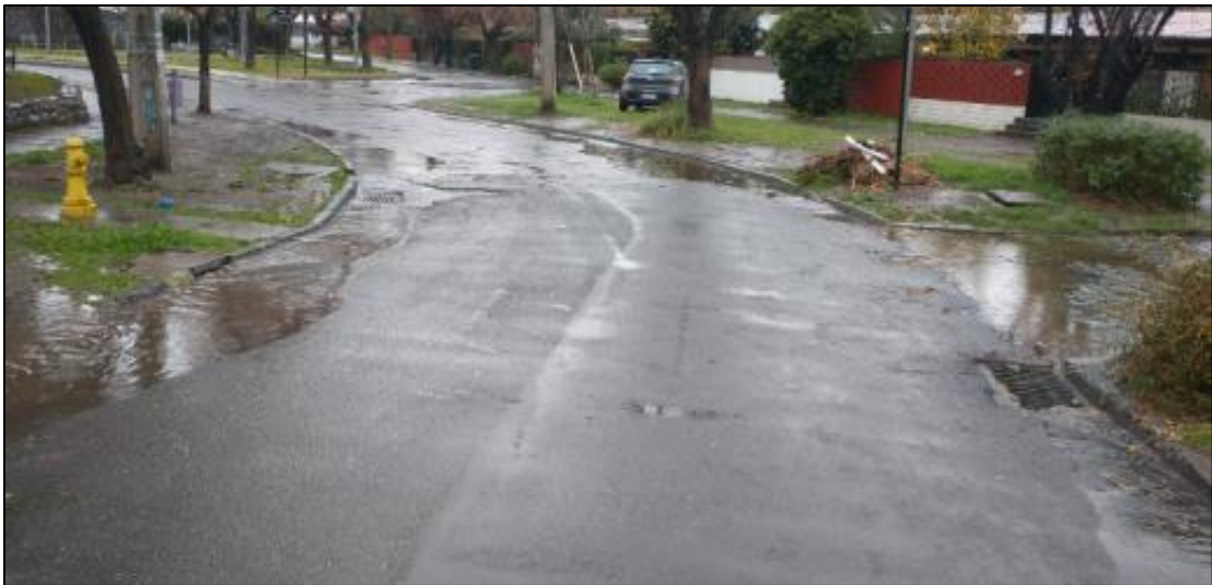
Figura n°14: Fotografía sector inundable de punto crítico. Fuente: M. La Reina – UGRD.
