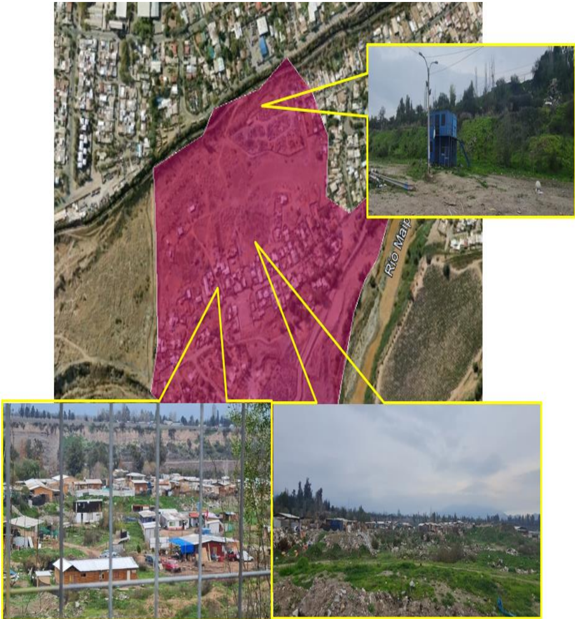
Figura N°23. Asentamiento “Los Areneros”
