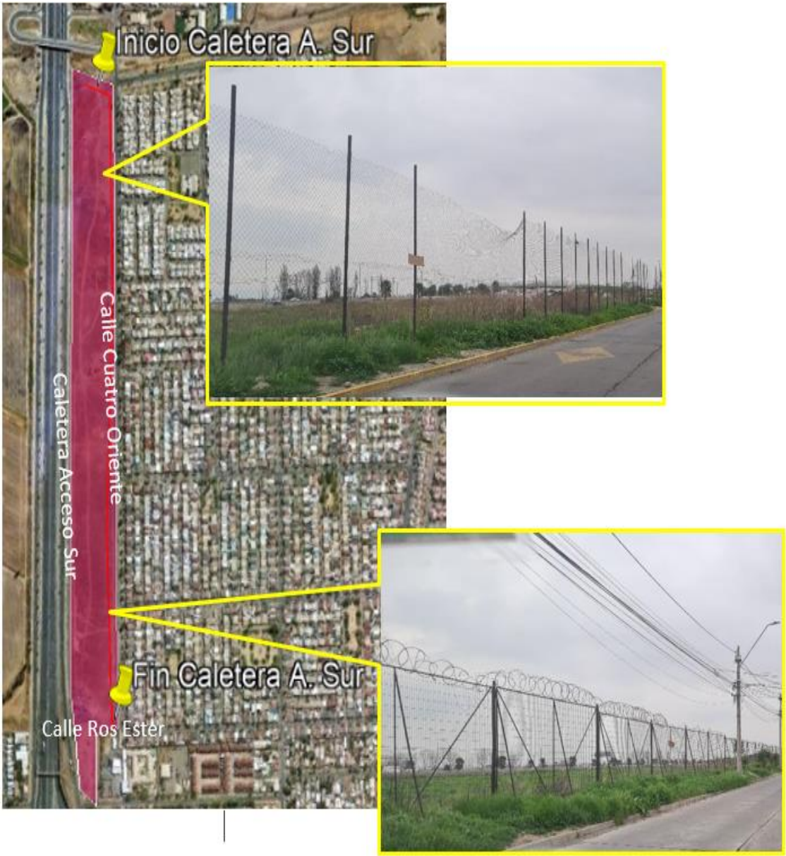
Figura N°18. Acceso Sur / Rosa Ester Fuente: Elaboración Propia, Evaluación en terreno GRD/ Dirección de Operaciones y Emergencia, Municipalidad de Puente Alto, a año 2023
