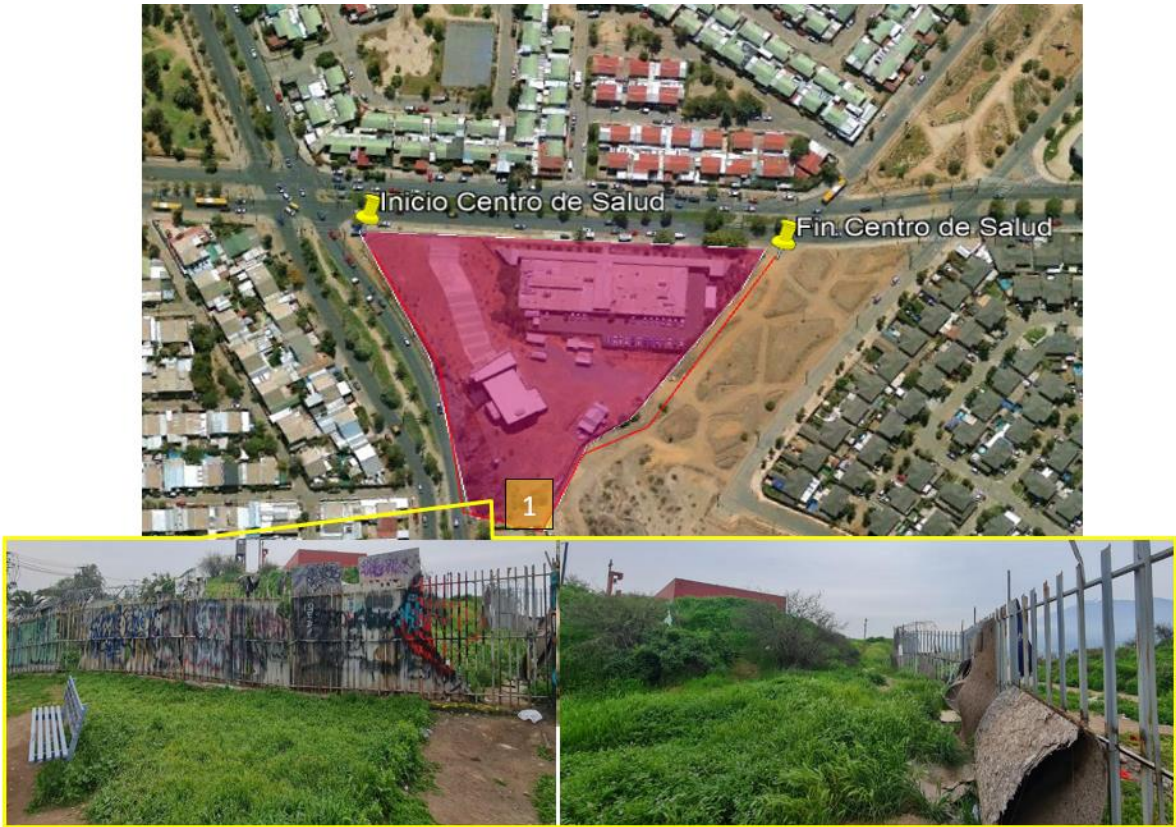
Figura N°27. Sector Norte Cerro La Ballena
