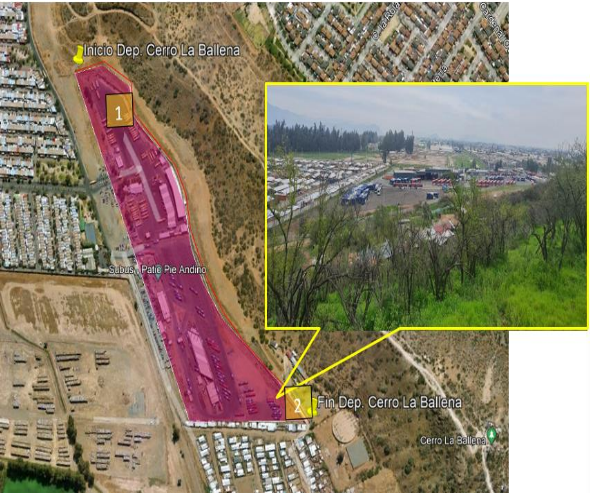
Figura N°26. Depósito/Terminal Subus – Sistema Red Cerro La Ballena
