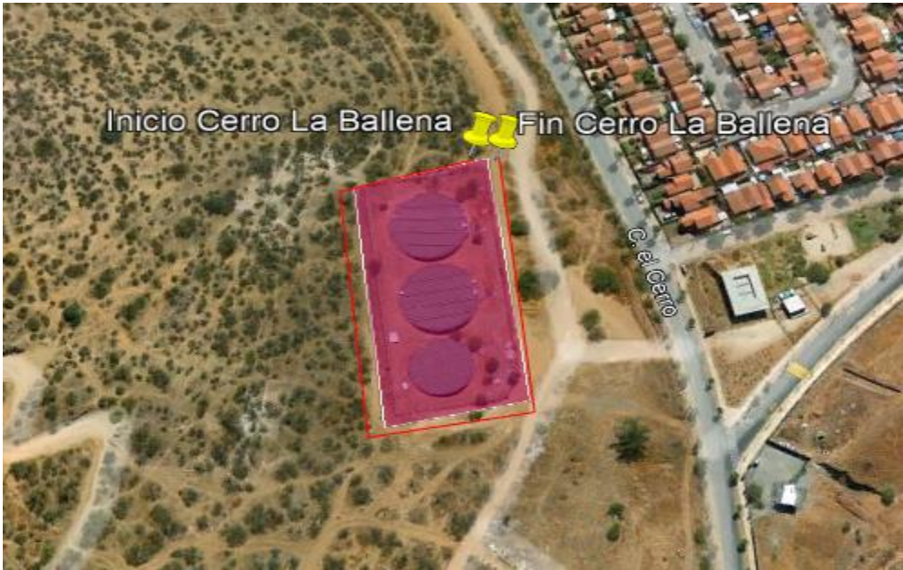
Figura N°31. Estanques Cerro La Ballena Fuente: Elaboración Propia, Evaluación en terreno GRD/ Dirección de Operaciones y Emergencia, Municipalidad de Puente Alto, año 2023
