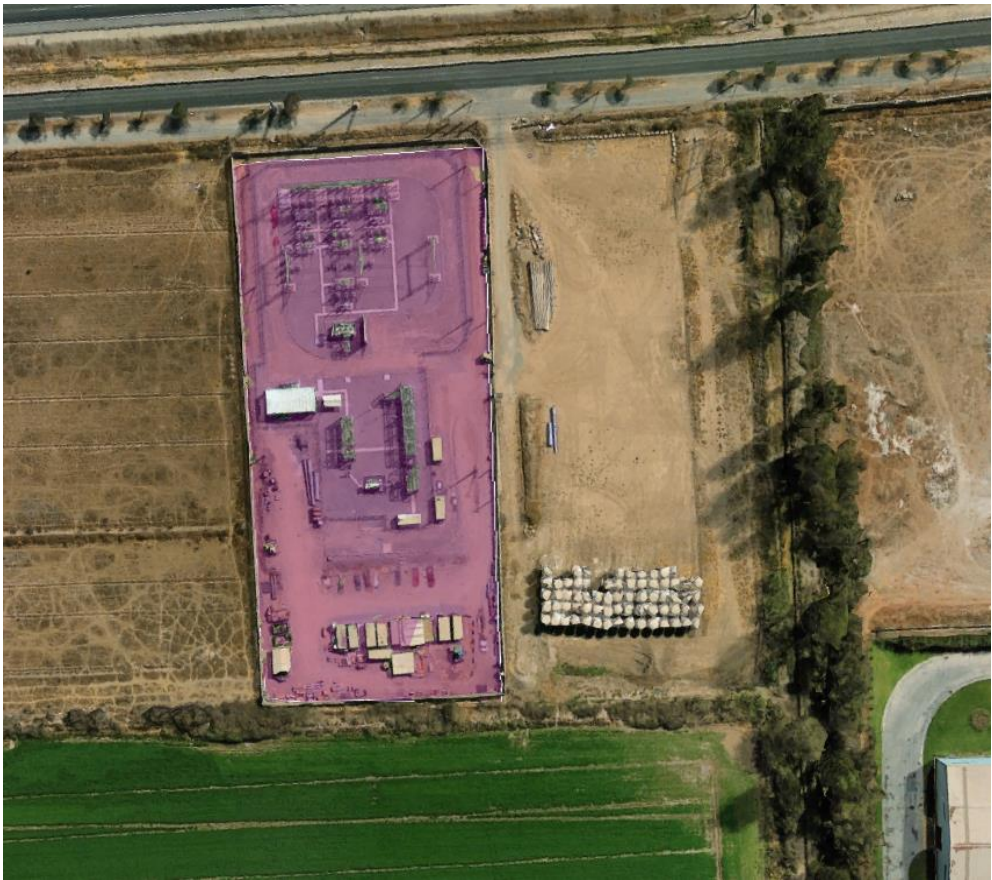
Figura N°22. Subestación Eléctrica Juanita Fuente: Elaboración Propia, Evaluación en terreno GRD/ Dirección de Operaciones y Emergencia, Municipalidad de Puente Alto, año 2023
