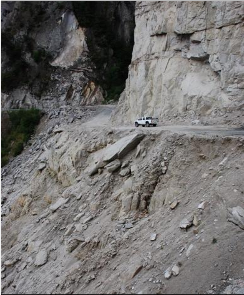
Figura 2: Paso en el sector la Candonga en la ruta X-731 hacia Puerto Sánchez.
