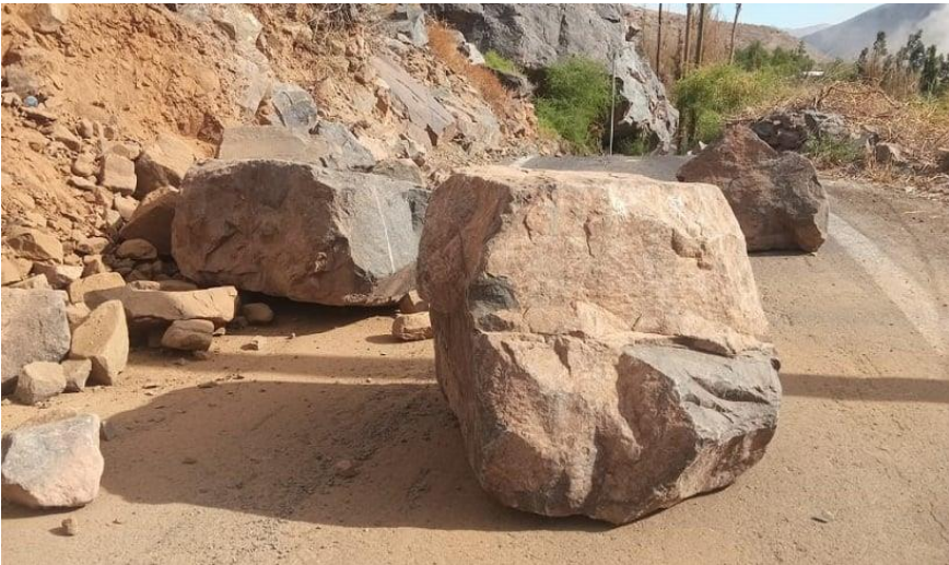
Imagen captada en Ruta C-489 en el sismo ocurrido el 31 de octubre de 2023. (Intensidad Mercalli VI) Fuente: Ilustre Municipalidad de Alto del Carmen (2023)
