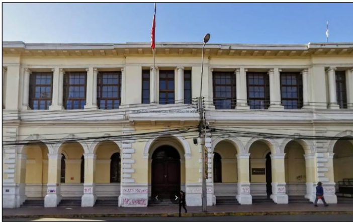
Figura N°2: Instalaciones del DPP Los Andes
