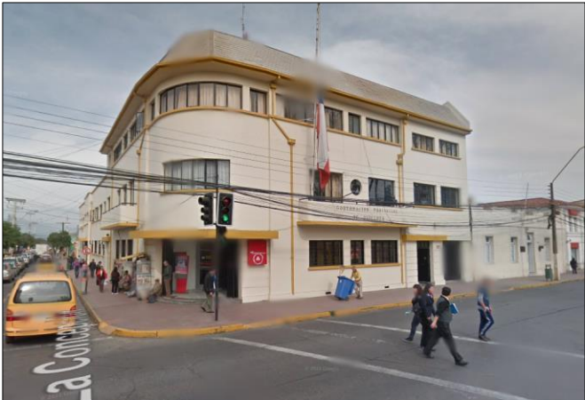
Figura N°2: Instalaciones del DPP Quillota
