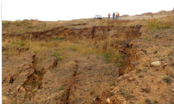
Imagen N° 2: Rotura producto de un proceso de Remoción en masa del tipo deslizamiento en el Relleno Sanitario de la comuna de Osorno. Fuente: SERNAGEOMIN (2024).
