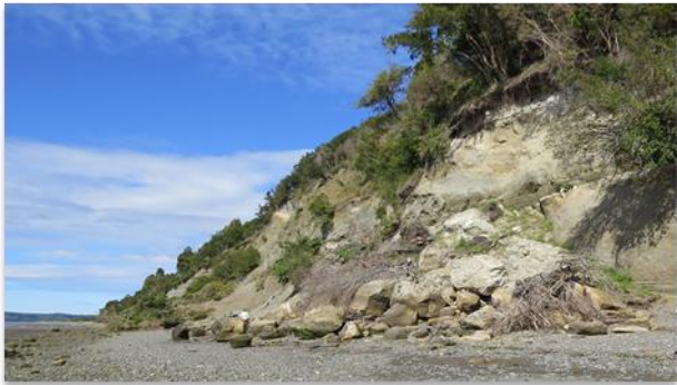
Imagen N°3: Proceso de “Caída” en las laderas del borde costero, Comuna de Ancud. Fuente: SERNAGEOMIN (2024).
