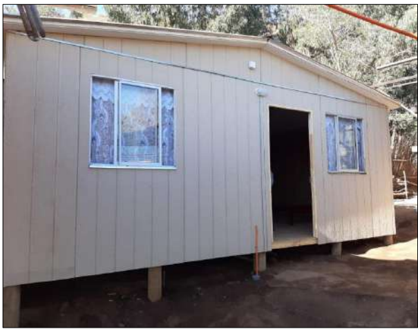
Figura 11. Malloa, Vivienda de Emergencia instalada en sector Cantarrana (Febrero 2021)
