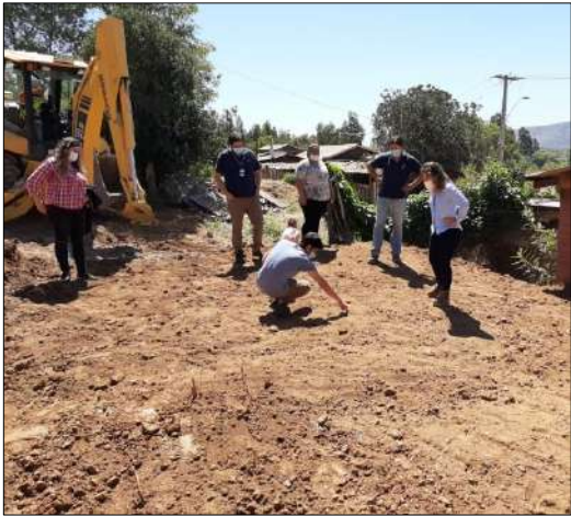
Figura 10. Malloa, visita inspectiva sector Caracoles (Febrero de 2021)
