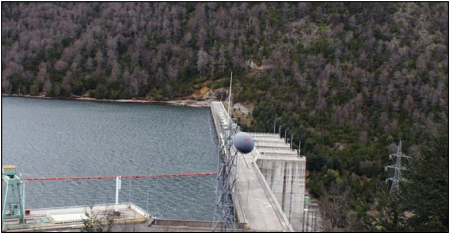
Figura 4: “Central Hidroeléctrica El Paso”.
