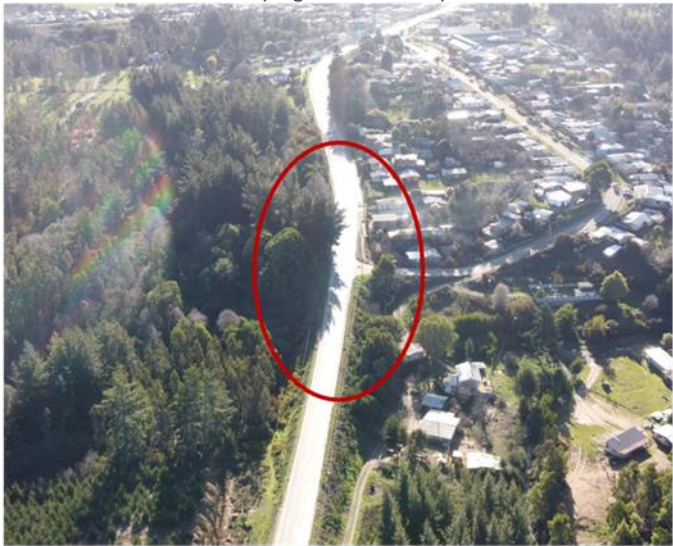
E – Ruta P-60-R sector Tres Pinos cruce peligroso en zona de pendiente
