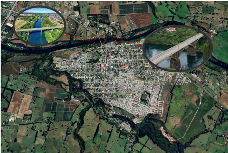
Puentes sector urbano de Río Bueno.
