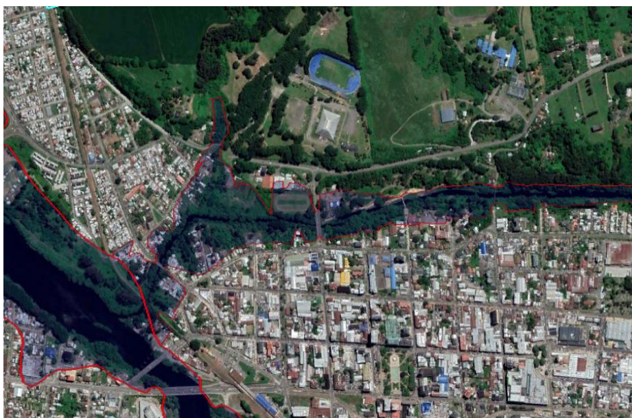
Imagen 5: Área inundable desbordes sector desembocadura Río Damas.
