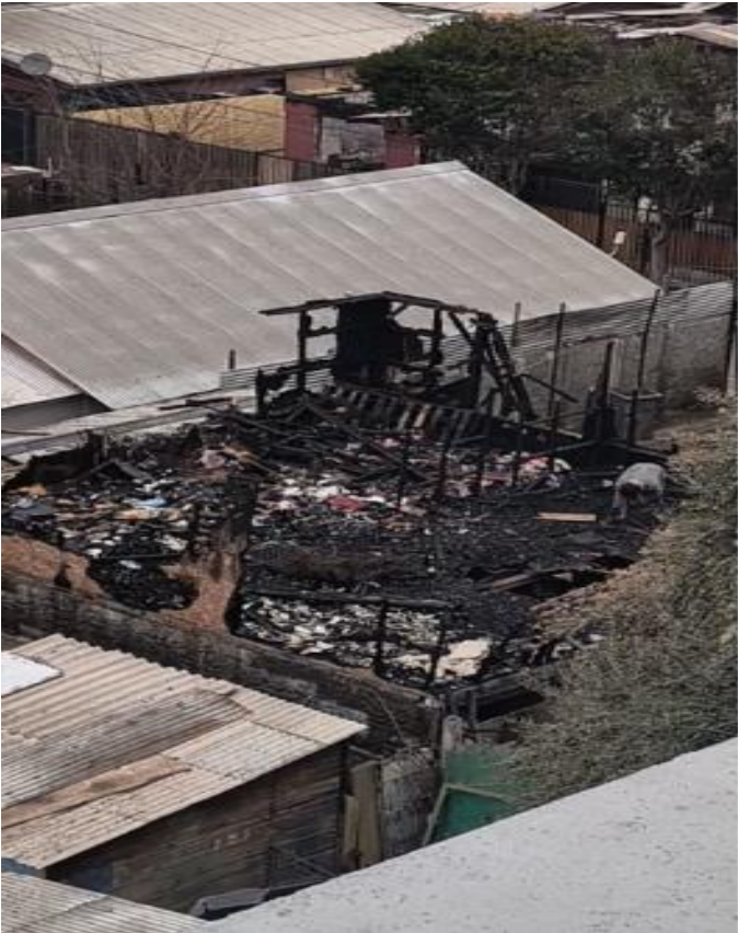
Imagen N°3 Elaboración propia incendio Asentamiento precario Los Arminios, Agosto2024.Desde altura.
