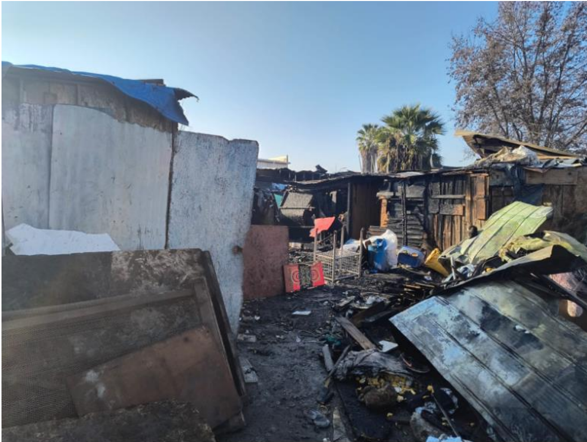
Imagen N°2 Elaboración propia incendio Asentamiento precario Los Arminios, Agosto2024.
