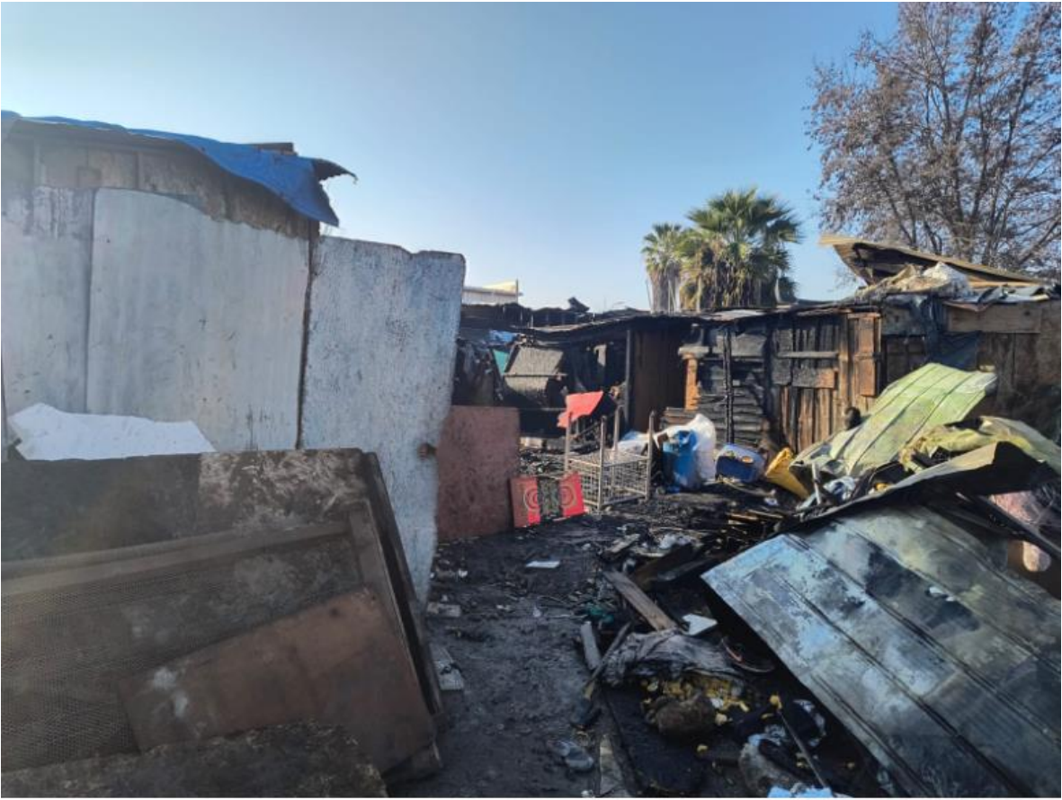
Figura N°11: Imagen elaboración propia incendio Asentamiento precario Los Arminios.
