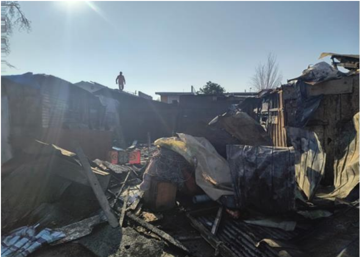
Imagen N°1 Elaboración propia incendio Asentamiento precario Los Arminios, Agosto2024.
