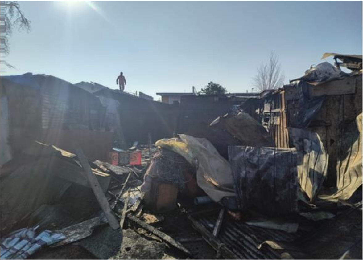
Figura N°10: Imagen elaboración propia incendio Asentamiento precario Los Arminios.
