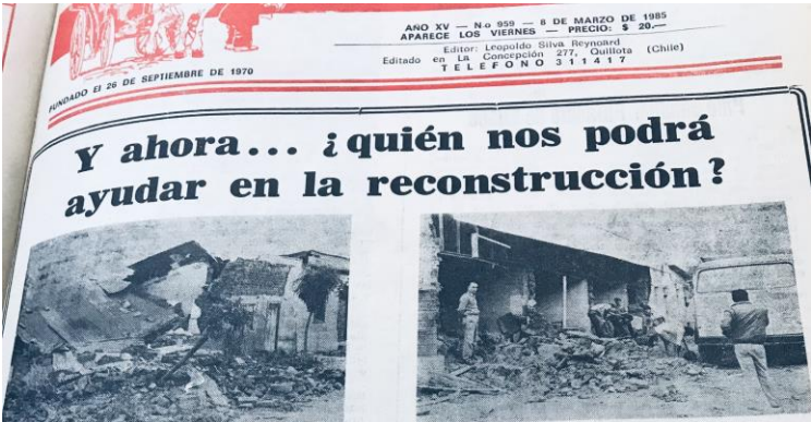
Imagen 2: Destrozos del terremoto año 1985.
