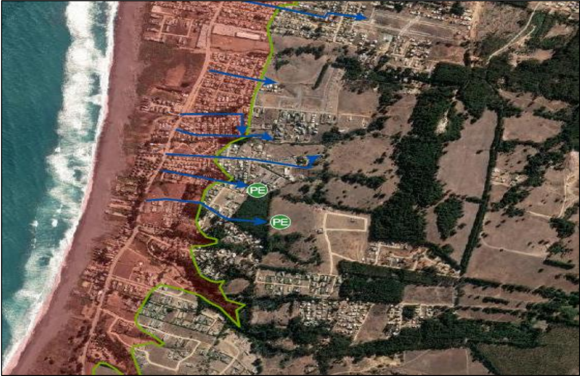
Las vías de evacuación, se encuentran plenamente identificadas y señalizadas a nivel comunal donde además se encuentran los puntos de encuentro Sector Playa Hermosa.
