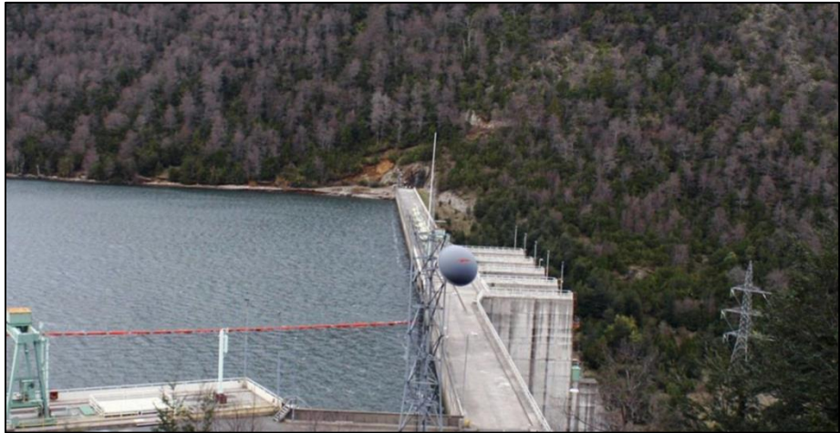
Figura 5: “Central Hidroeléctrica El Paso”.
