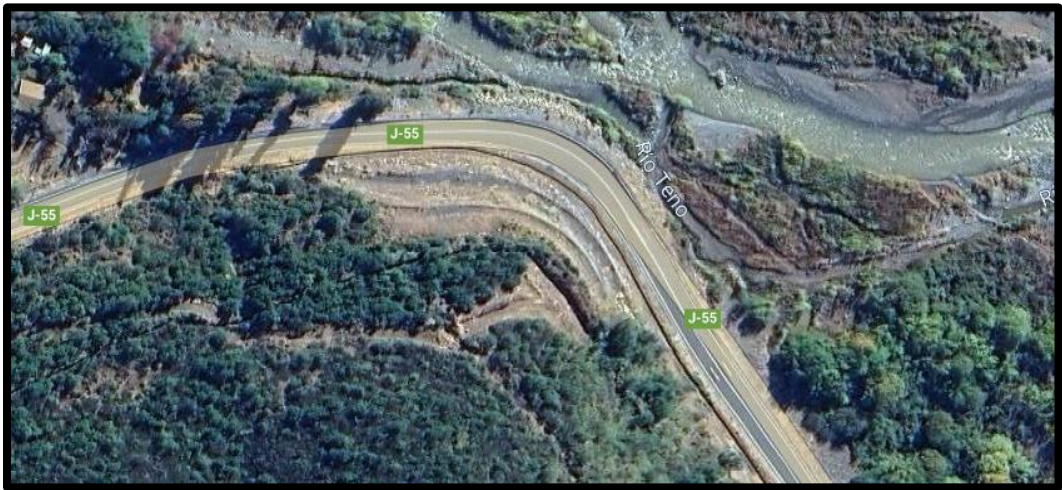
Imagen N°11: Sector J-55 Km 30 Georreferencia 34°98'39"S 70°88'37 "W
