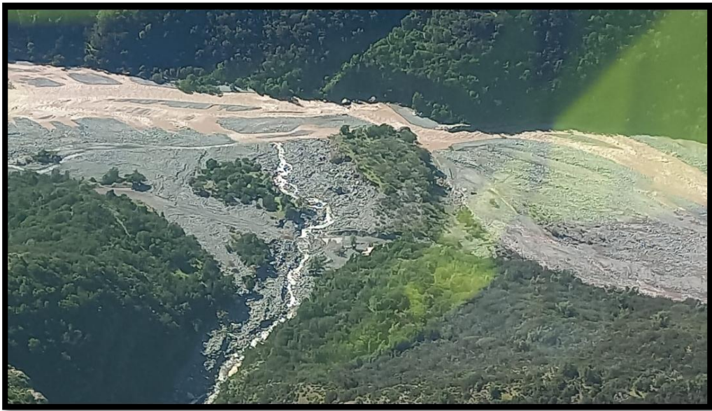
Deslizamientos de gran cantidad de material Quebrada Favio corte total de la ruta
