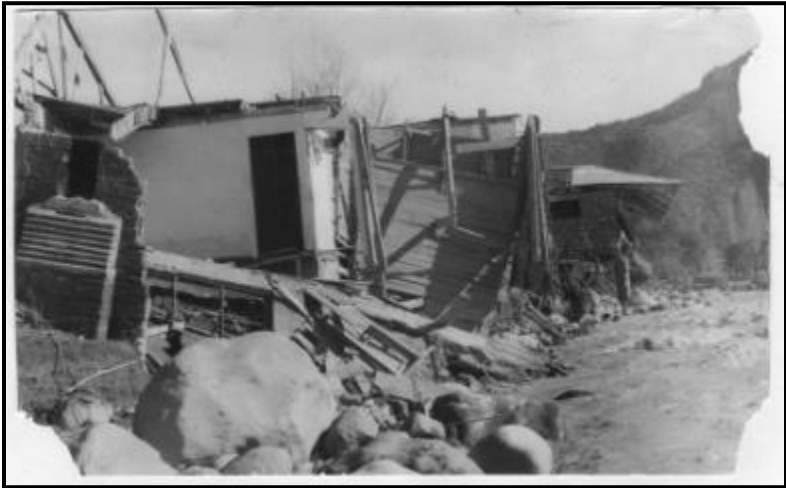
Así quedaron las viviendas de los habitantes del sector de los Queñes.
