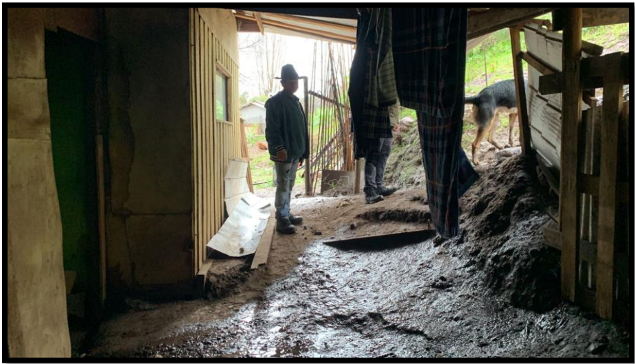
Deslizamiento de material de ladera de cerro sobre vivienda en sector La Unión Ruta J-55 km25.4
