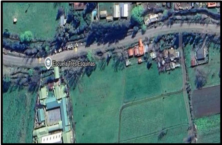
Imagen N°33 Ruta J-59 sector Santa Inés Georreferencia 35°04'05"S 71°04'31 "W
