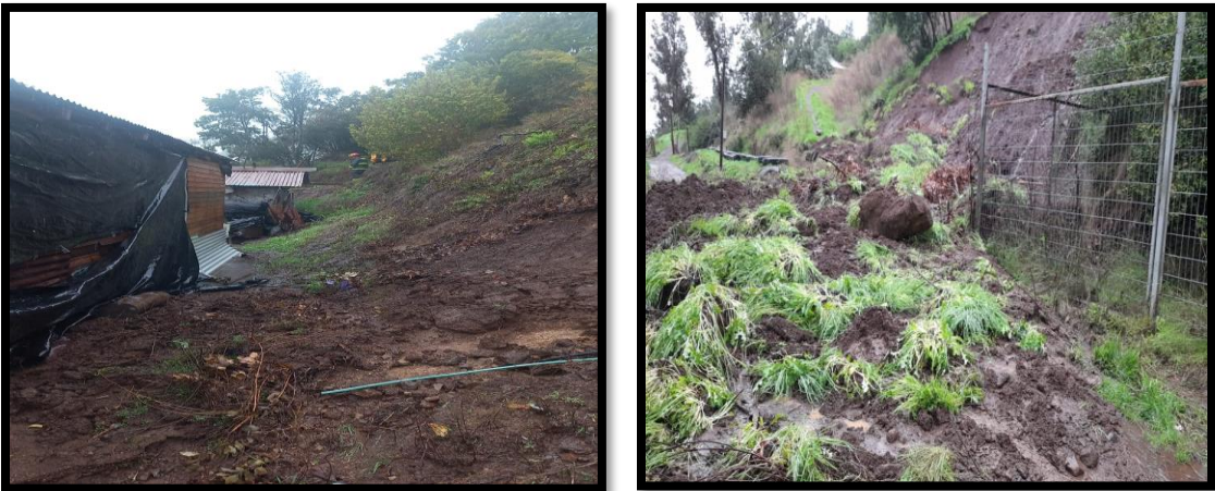
Deslizamiento de material sobre dos viviendas callejón el Socavón Junio 2023.
