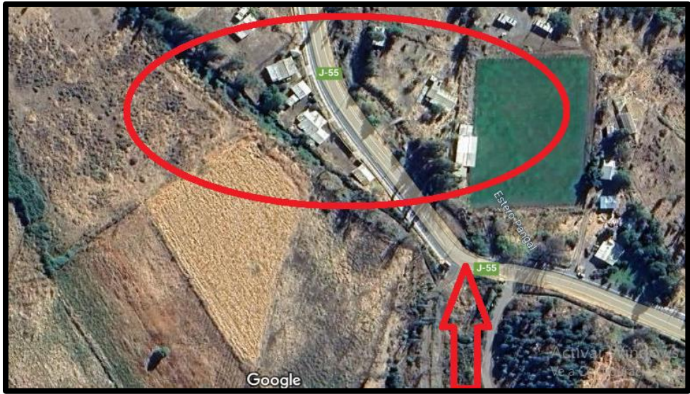
Imagen N°6: Sector puente el Durazno, activación de quebrada km 33 Ruta J-55 Georreferencia 34°99'66"S 70°85'29 "W
