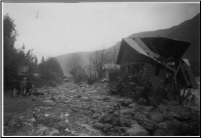
El deterioro de las viviendas después del desastre.
