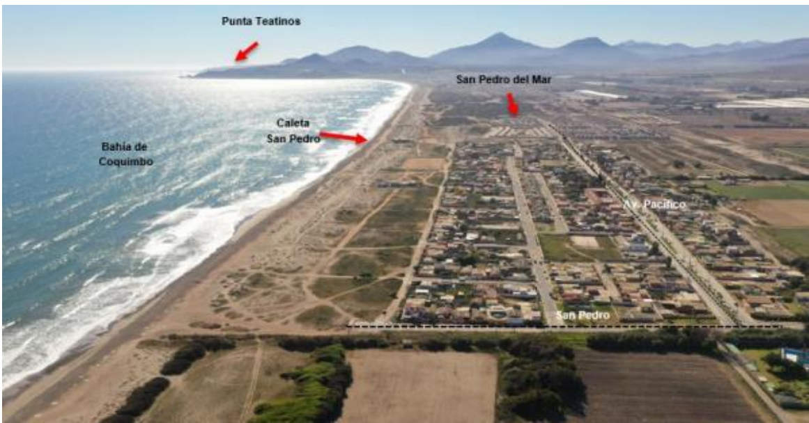
Vista del Sector Caleta San Pedro
