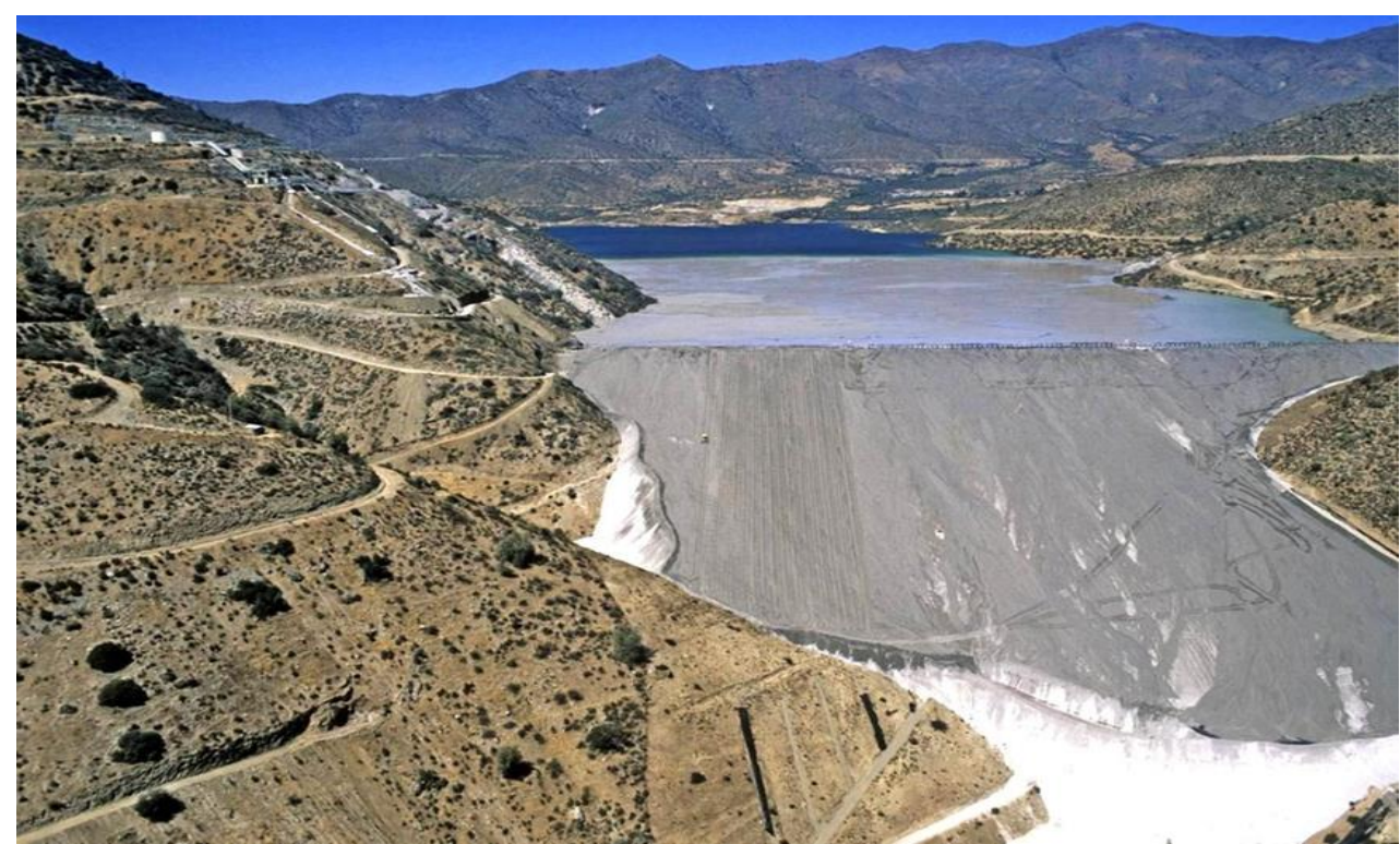
Muro principal Tranque de relave El Mauro
