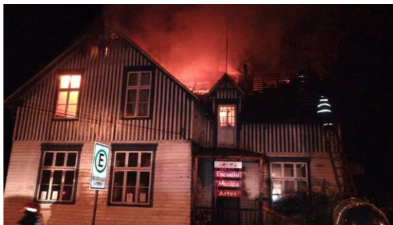
Incendio casa Schmidt (sept 2019)
