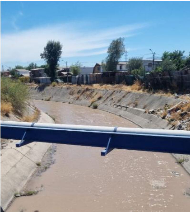
Imagen N°6 Obras de Mitigación Zanjón de la Aguada
