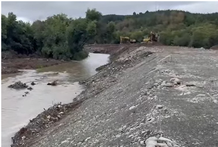
Construcción terraplén sector Canchiuque
