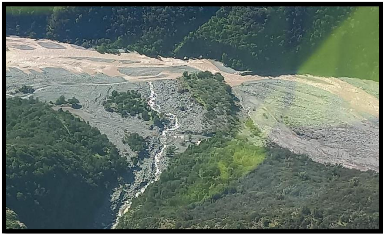
Imagen N°6 Remoción en masa Quebrada de Fabio, destruye refugio, arrasa con zonas de camping y corte total de la ruta J-55
