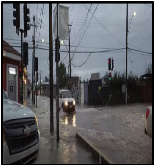
Imagen N°3 Desborde Canal La Cañada 21/03/2023
