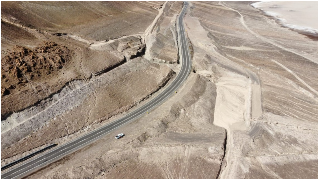
Fotografía, captación de escorrentía en ladera
