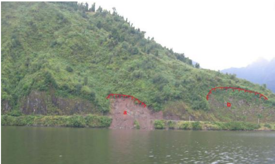
Imagen 11 Deslizamientos que afectan la Carretera Austral, en la cercanía del Lago Risopatrón. Se indica un deslizamiento reciente (a) y la cicatriz de deslizamiento antiguo 12
