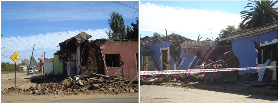
FUENTE: Repositorio de la Biblioteca municipal de la comuna de Río Claro
