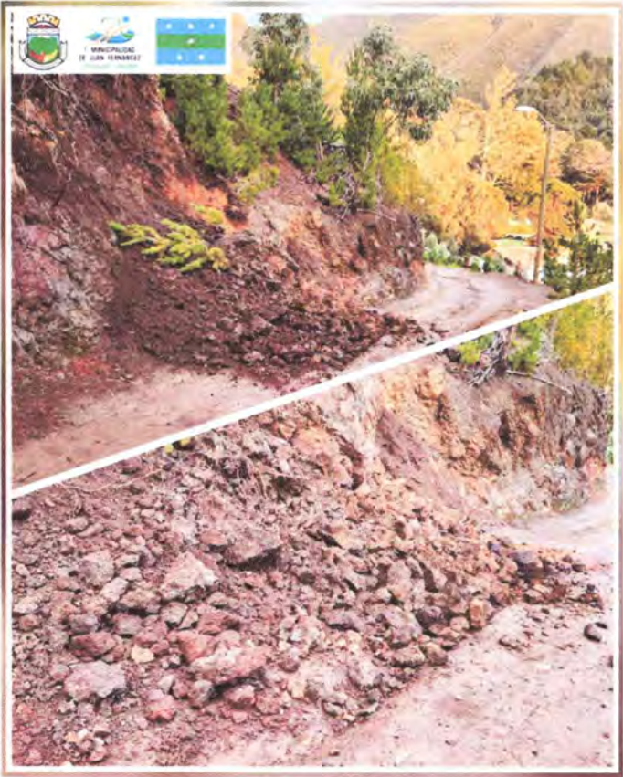
Afectación de ruta
