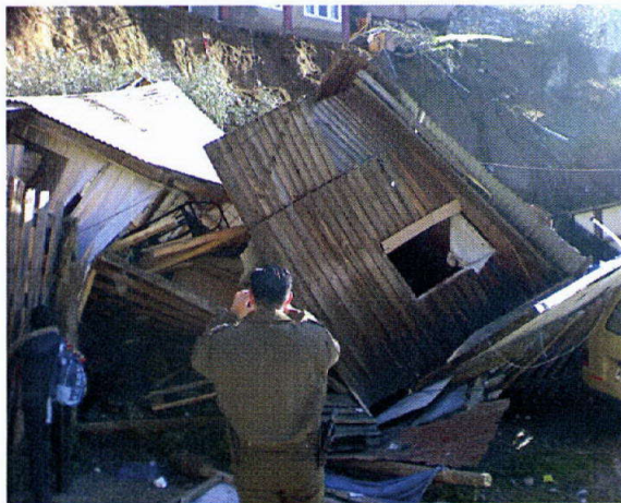
Fotografía N°5: Vivienda Destruída Cerros Valparaíso
