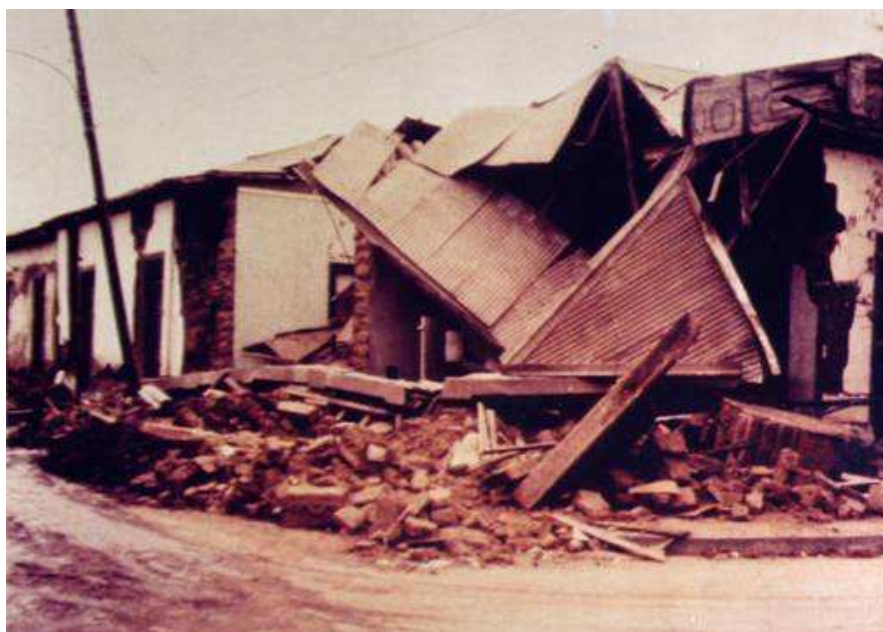
Fotografía 1: Daños en viviendas producto terremoto de 1985
