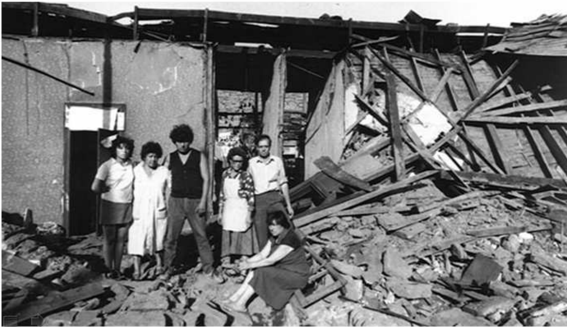
Fotografía 4: Daños producidos por el terremoto
