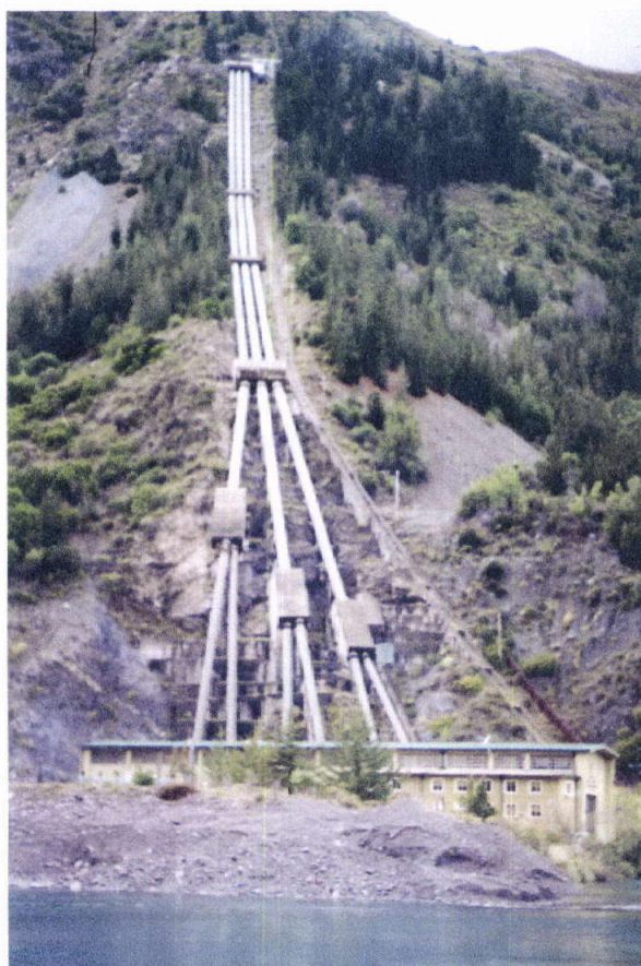
Foto N° 8. Central Hidroeléctrica Cipreses ubicada en zona de riesgo.
