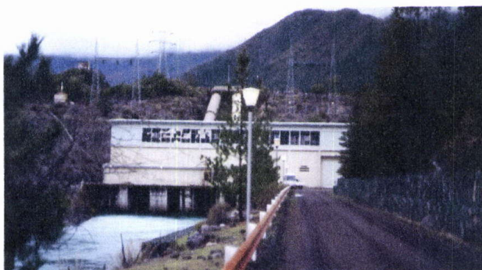
Foto N° 9. Central Hidroeléctrica Isla ubicada en zona de riesgo.
