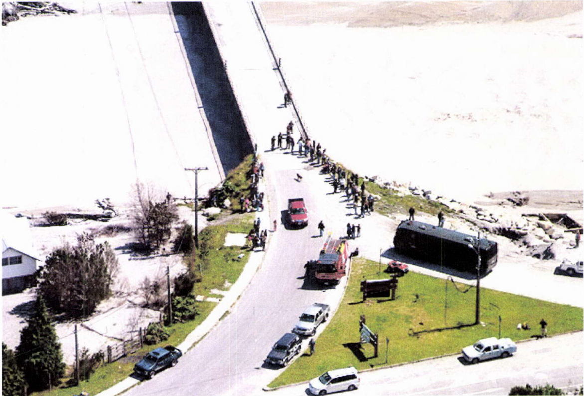
Puente de Chaitén.
