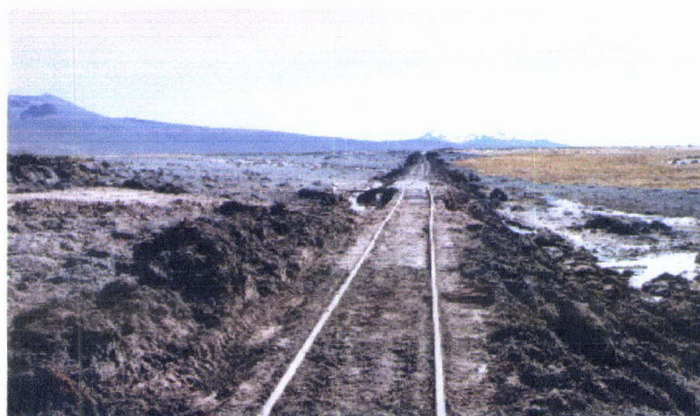
Fig 19: Cuatrocientos metros de línea del ferrocarril Arica-La Paz, obstruidos por el lodo
