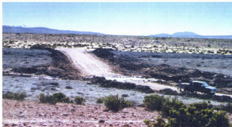
Fig 17: Camino Visvirri-Alcérreca, afectado por el proceso de Remoción en Masa.
