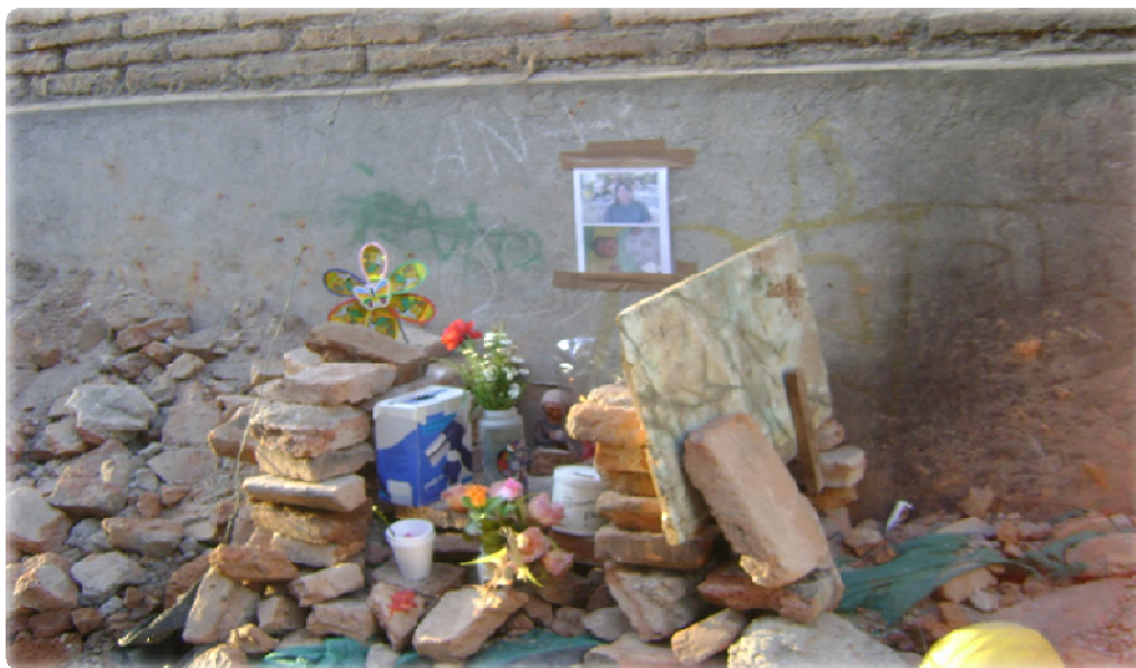
Foto 6: “Animita” en recuerdo de la Sra. Lourdes Armas y su hija Florencia en el lugar en que murieron por la caída de una cornisa a causa del terremoto.
