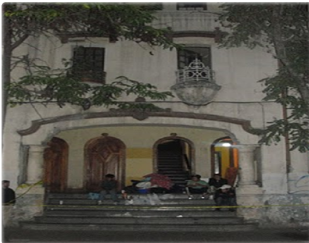
Foto 5: Migrantes pasando la noche a la intemperie por temor a las réplicas el peligro de derrumbe de sus viviendas en el centro de Santiago.
