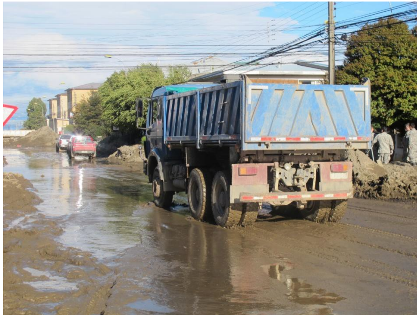
Foto N°8 Utilización de camiones para el despeje de barro
