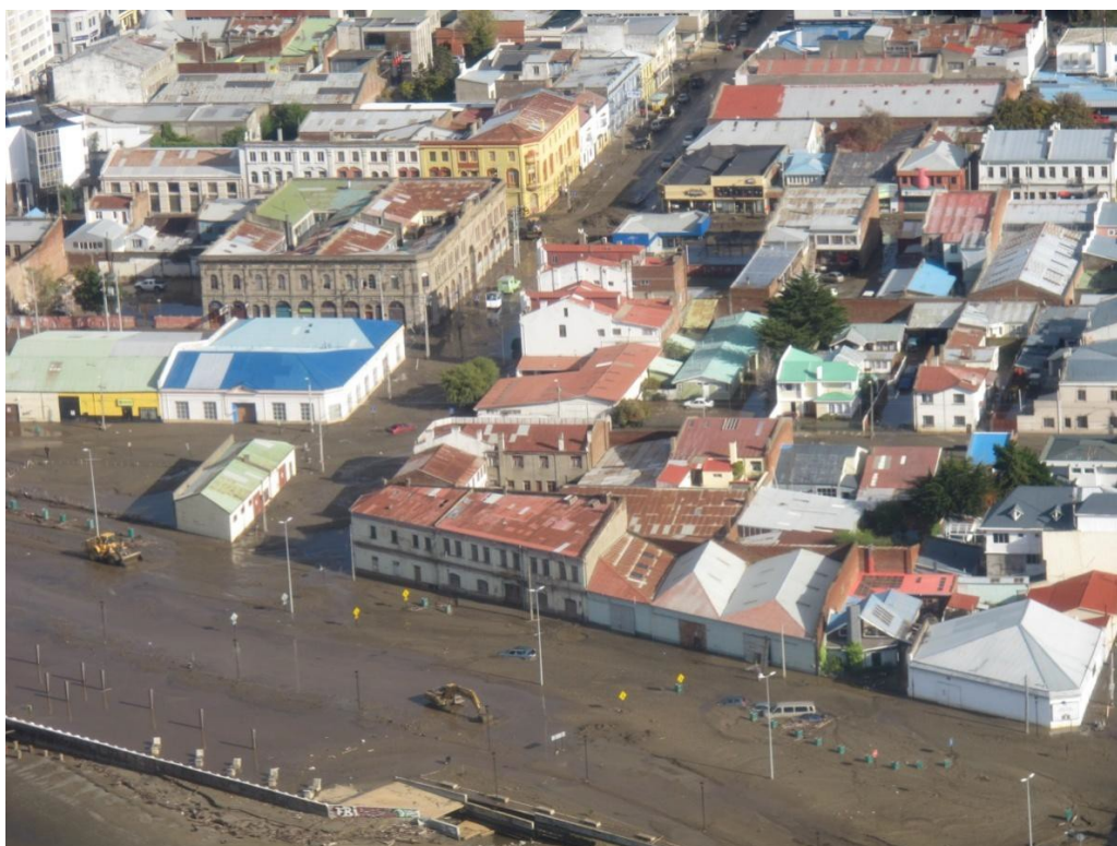
Foto N°3 Vista aérea de un sector de Punta Arenas con sus calles cubiertas de barro
