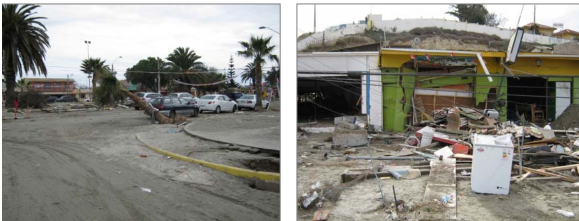
Figura 13. Efectos del Tsunami en sector del centro del balneario de Tongoy.
