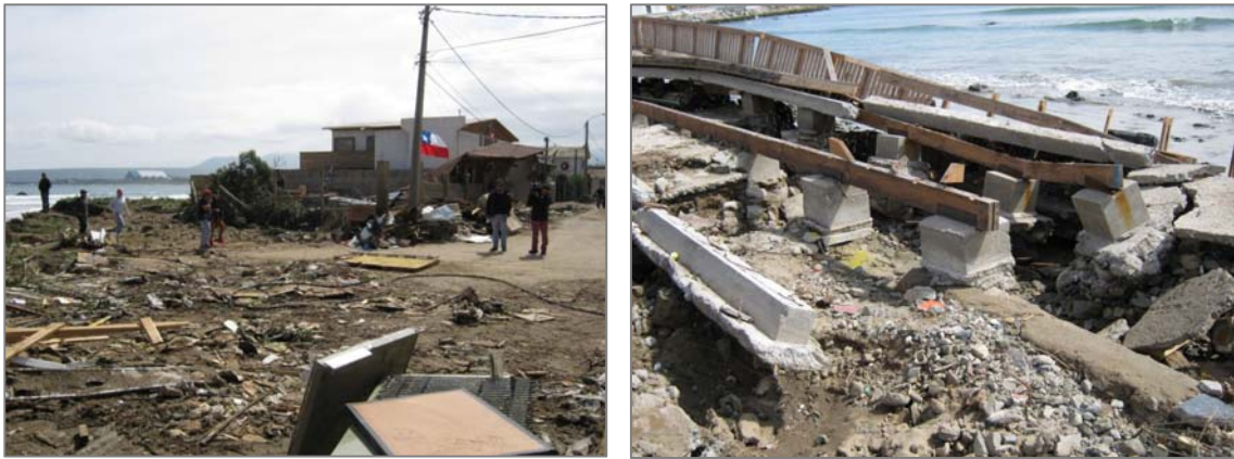
Figura 12. Efectos del Tsunami en casas ubicado en el sector de Av. Costanera, Los Vilos.
