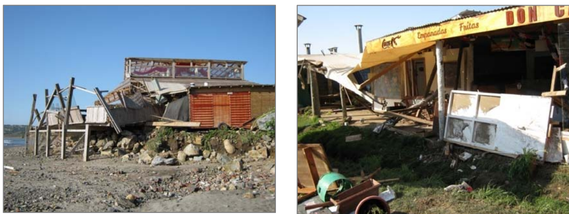
Figura 11. Efectos del Tsunami en local ubicado en el sector de Playa La Boca, Concón.
