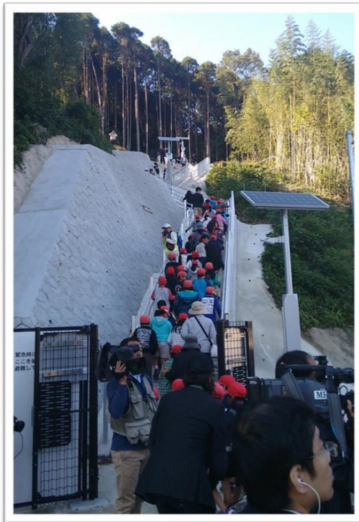
Escalera de evacuación del puerto de Hososhima
