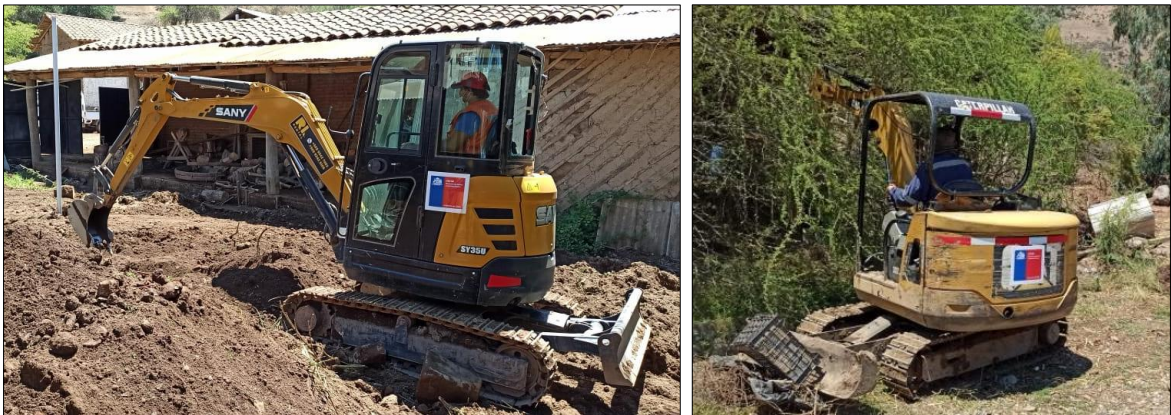
Figura 9. Maquinaria trabajando en evento de enero 2020, Región de O'Higgins.
