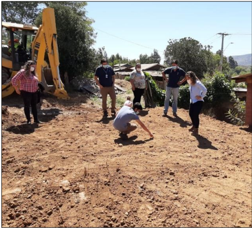
Figura 10. Malloa, visita inspectiva sector Caracoles (Febrero de 2021)
