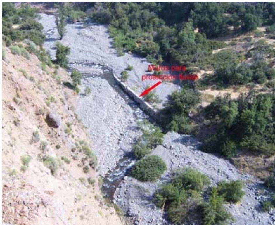
Figura 5.22. Muros para protección fluvial destruidas por los flujos de 1993.
