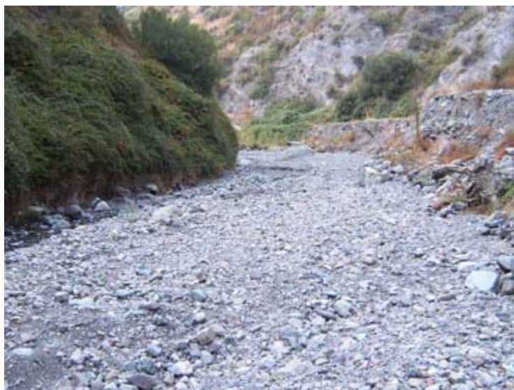
Figura 5.9. Depósitos aluviales recientes en cauce de Quebrada San Ramón (tramo inferior).
