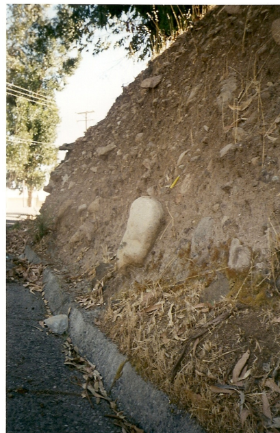
Fotografías N°9: Corte Talud
