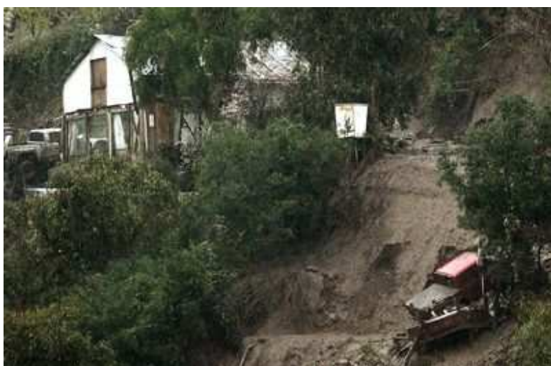
Foto N°5 Destrucción tras el paso del aluvión
