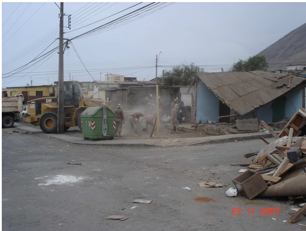
Fotografía N° 4: Trabajo de remoción de escombros.
