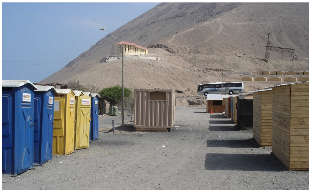
Fotografía N° 6: Baños químicos instalados.
