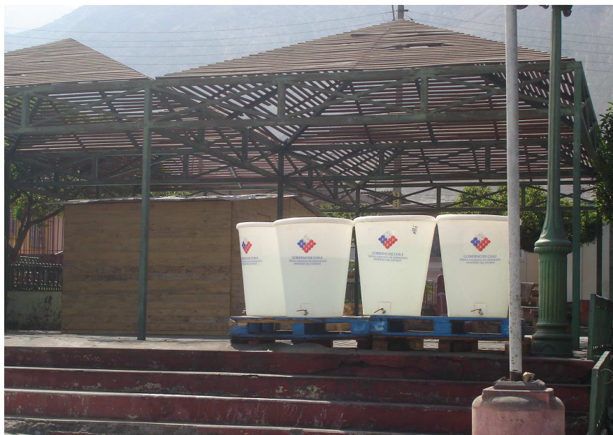
Fotografía N° 5: Estanques para agua potable.
