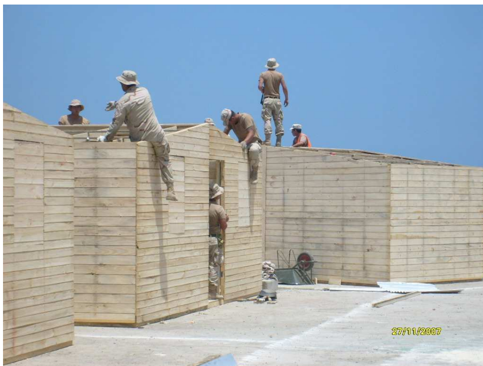
Fotografía 1: Instalación de viviendas de emergencia en Tocopilla.
