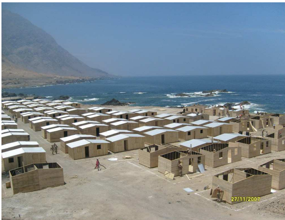
Fotografía 2: Viviendas de emergencia instaladas en Tocopilla.
