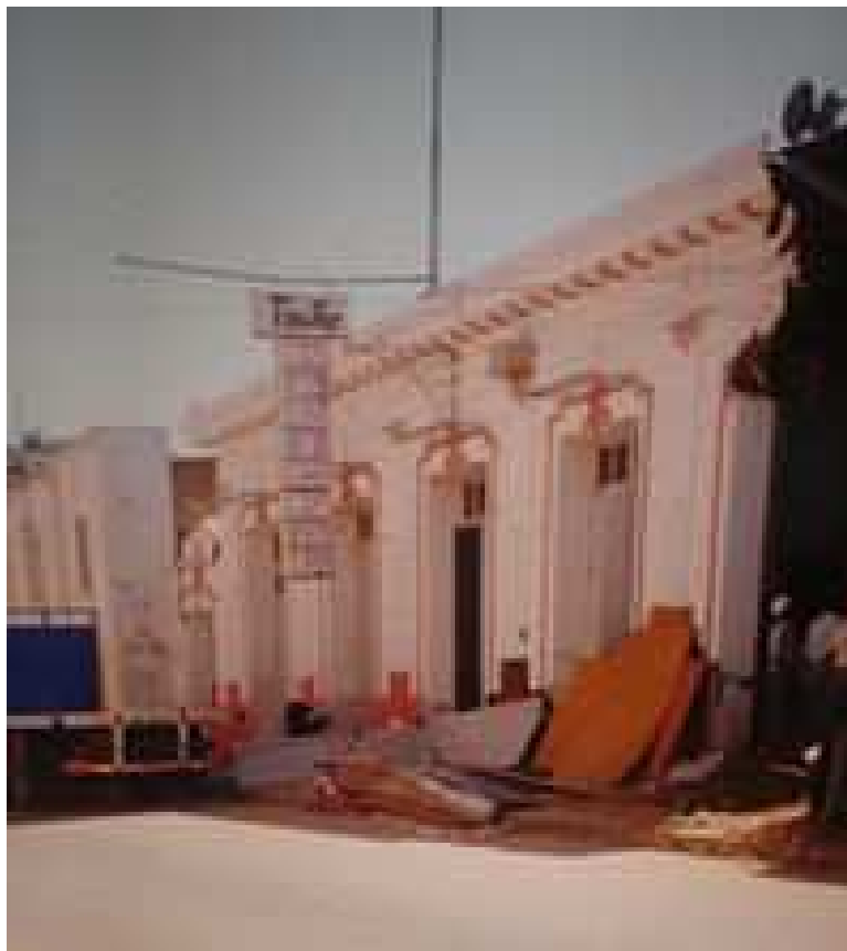
Fotografía 3: Teatro Nacional de Ovalle después del terremoto
