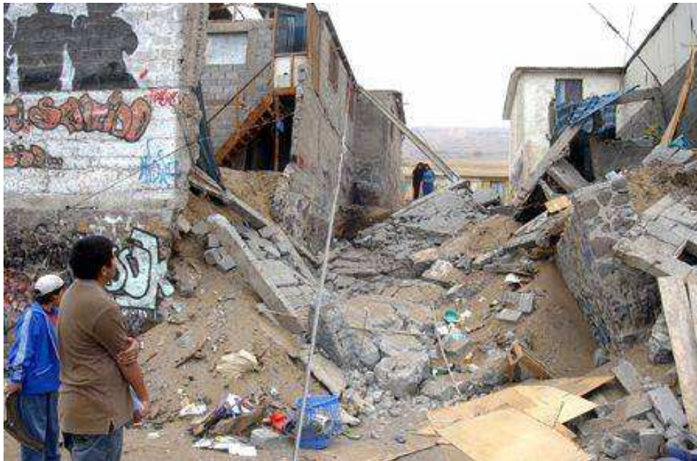
Fotografía 1: Terremoto Tarapacá, 13 de junio 2005.
