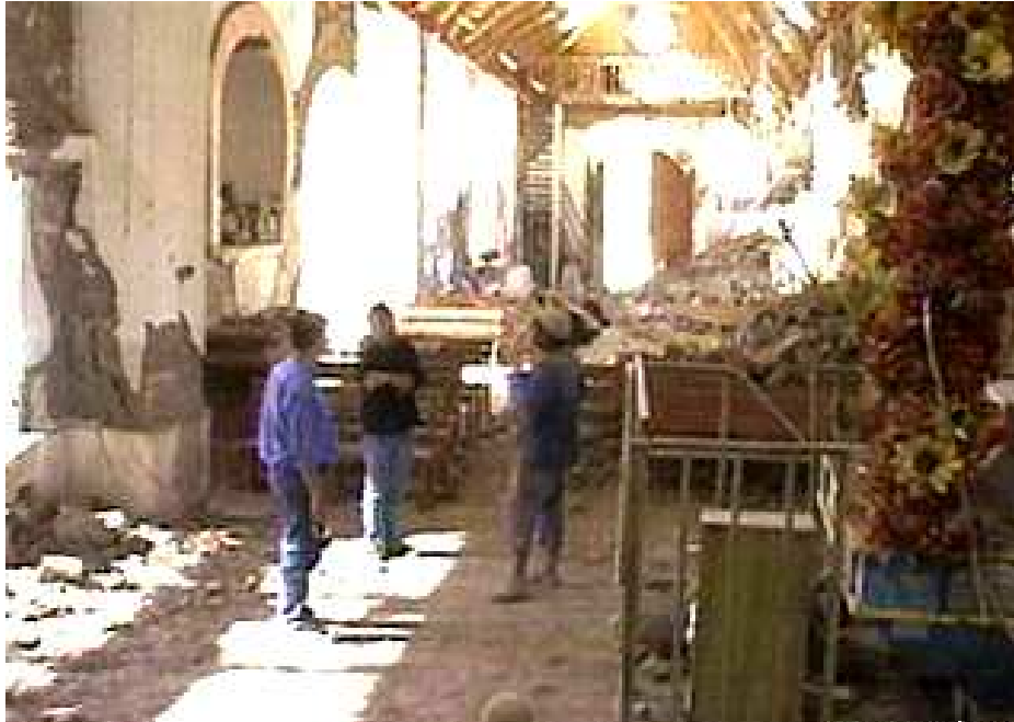
Fotografía 2: Vaciamiento de muros en Iglesia San Lorenzo de Tarapacá.
