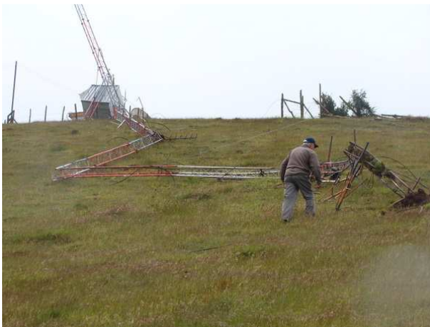
Fotografías N°1 y N°2: Colapso Antena de Radio
