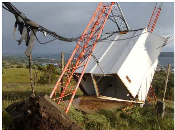
Fotografías N°1 y N°2: Colapso Antena de Radio
